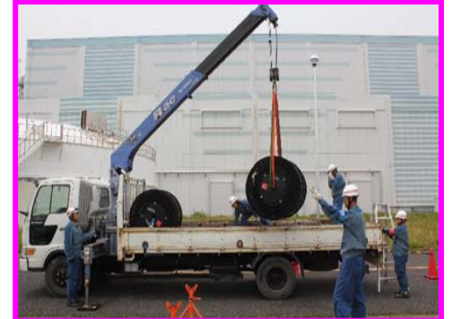
所員によるケーブルドラムの移動
