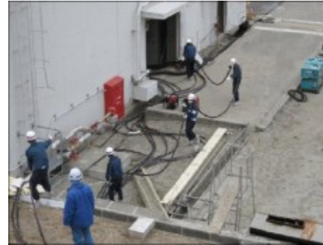
仮設ケーブル布設の当時の様子
