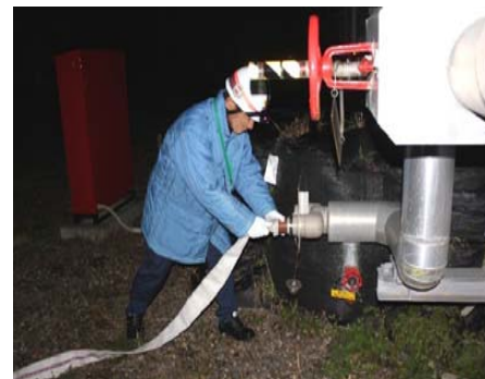
原子炉建屋送水口への消防ホース接続
