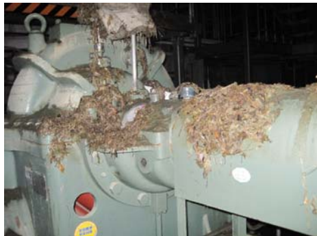
津波によるポンプ被水の当時の状況
