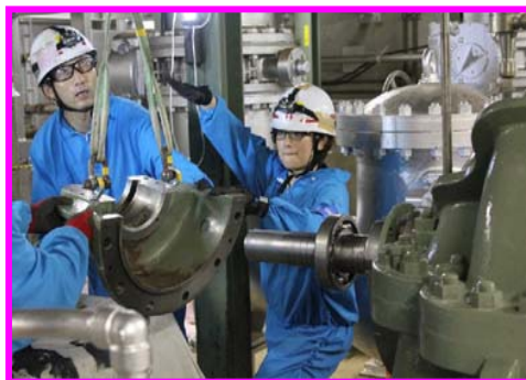
ポンプ軸受カバーの組み立て
