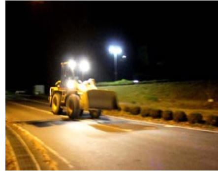
現場へ向かう重機
