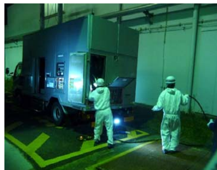
電源車からのケーブル引き出し
