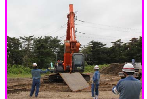
埋め戻した箇所への鉄板設置
