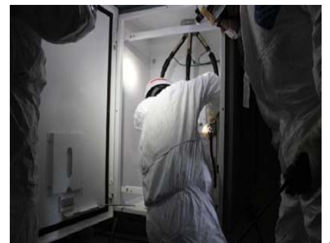
ケーブル接続箱へのつなぎ込み
