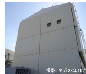
建屋カバーの設置状況
