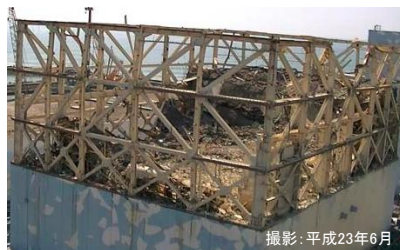
建屋カバー設置前の状況
