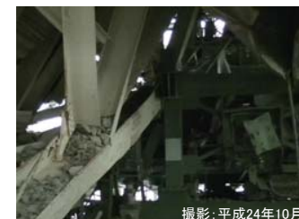
建屋カバー内の状況
