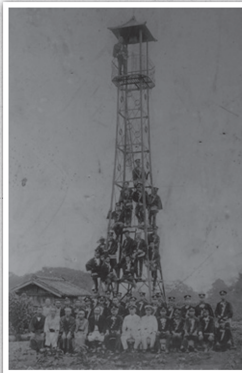
上小埜鉄製火の見櫓建設記念(昭和10年)
