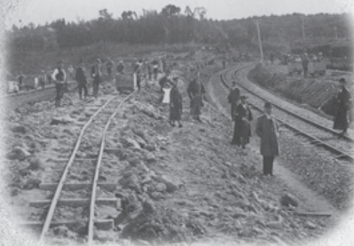
竜田駅建設工事(明治41年)
