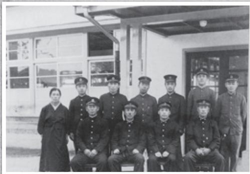
竜田駅駅舎落成(昭和14年)
