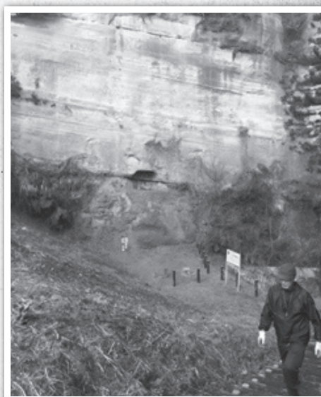
町と東電による岩沢磨崖仏の保全活動(平成28年)
