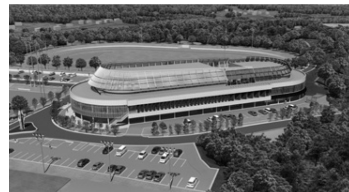
③国道6号線に近く常磐自動車道からも望める外観
