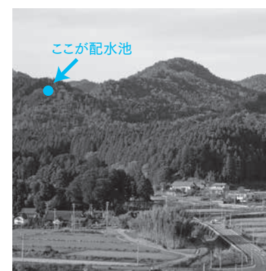
北林配水池(町内の約90%の家庭へ)
