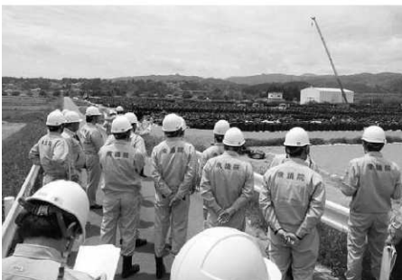
仮置場の状況を視察
