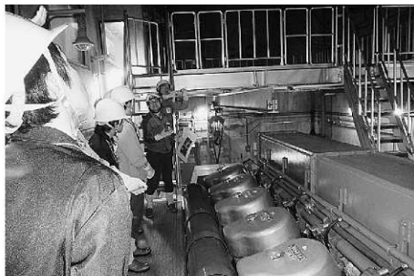
現地調査（1号機原子炉建屋）
