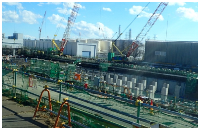
▲廃棄物関連設備の建設工事
