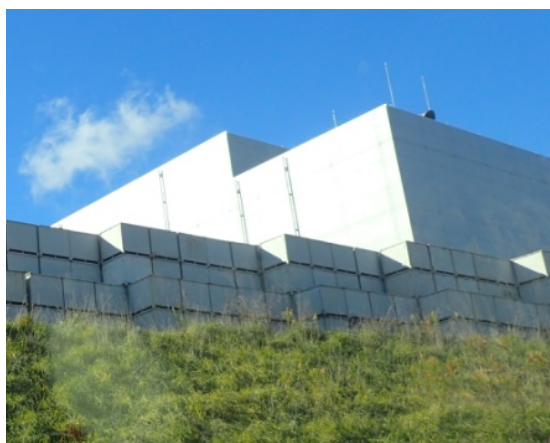
▲固体廃棄物焼却設備
