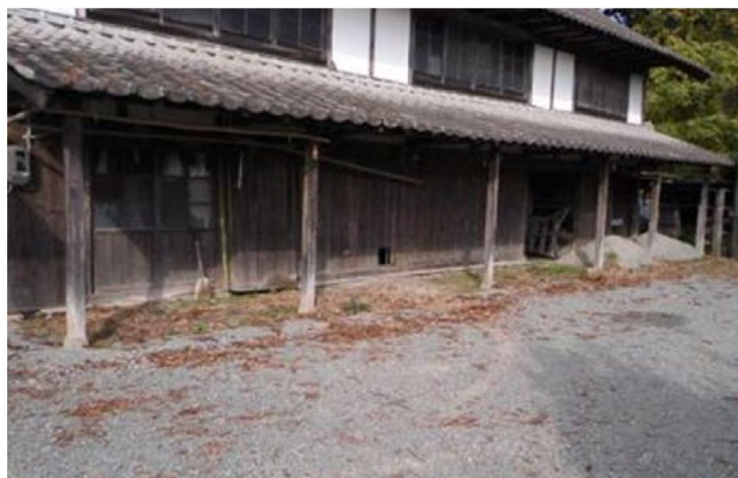
施工前の様子
