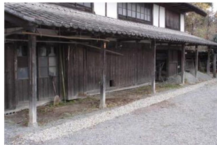
施工後の様子
