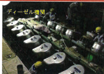
1号機 非常用D/G (A) 復旧作業
