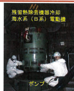
残留熱除去機器冷却海水系 (B系) 電動機 電動機の据付作業
