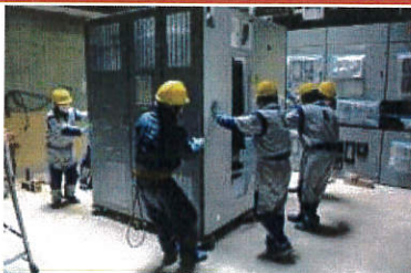
1号機 電源盤 (P/C 1C-1) 据付作業
