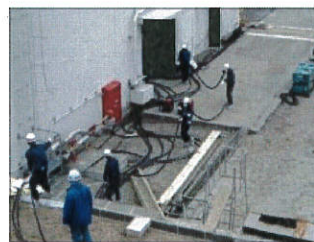
仮設ケーブルの布設の様子
