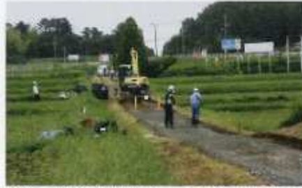
農地の除染(繁岡地区) 2013年7月24日 畦道の除染を行っています。畦道は除草を行い、5cm程度の剥ぎ取りを行います。その後、土地に客土を行い畦道を築立し法面を仕上げて元の現況高まで復旧します。
