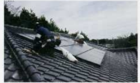
屋根の除染(上小埧地区) 2013年7月19日 瓦屋根は瓦を1枚1枚拭き取りにより除染を行います。
