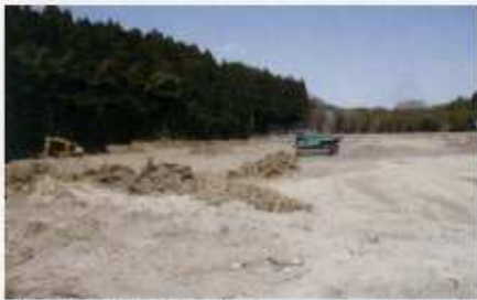
松館・旭ヶ丘地区仮置場 左:2013年3月26日 右:2013年7月23日 昨年12月から造成工事が始まった松館・旭ヶ丘地区の仮置場は、現在では整地工事等を終え除染廃棄物が搬入されています。松館・旭ヶ丘地区の除染工事が終了し、全ての除染廃棄物の搬入を終えた段階で、除染廃棄物を入れた大型土のう袋のまわりに汚染されていない土を入れた大型土のう袋を置いて覆へし、さらに遮水シートで被います。そして遮水シートが風などで飛ばないように耐久性を有する押え土のうを設置していきます。
