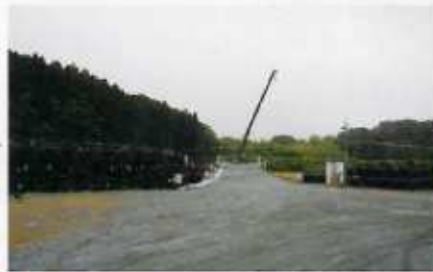
松館・旭ヶ丘地区仮置場 左:2013年3月26日 右:2013年7月23日 昨年12月から造成工事が始まった松館・旭ヶ丘地区の仮置場は、現在では整地工事等を終え除染廃棄物が搬入されています。松館・旭ヶ丘地区の除染工事が終了し、全ての除染廃棄物の搬入を終えた段階で、除染廃棄物を入れた大型土のう袋のまわりに汚染されていない土を入れた大型土のう袋を置いて覆へし、さらに遮水シートで被います。そして遮水シートが風などで飛ばないように耐久性を有する押え土のうを設置していきます。
