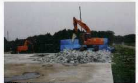
上繁岡地区仮置場 2013年7月12日 上繁岡地区の仮置場では除染廃棄物減容施設の解体が進んでいます。減容施設の土台のコンクリートは重機等を使って解体され、搬出されます。
