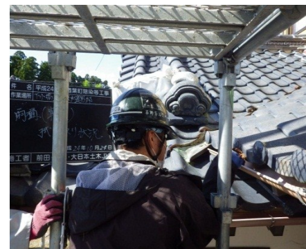
樋の除染(拭き取り・高圧水洗浄)
