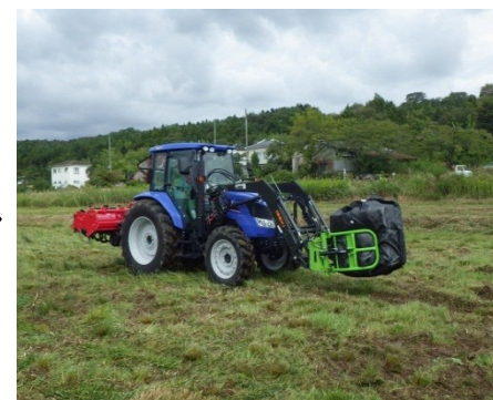
耐候性大型土のうへの袋詰め、運搬、集積
