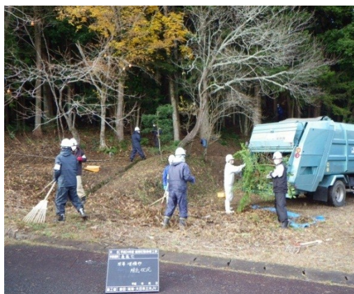
堆積物の除去状況
