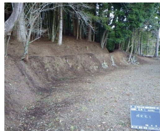
施工完了状況
