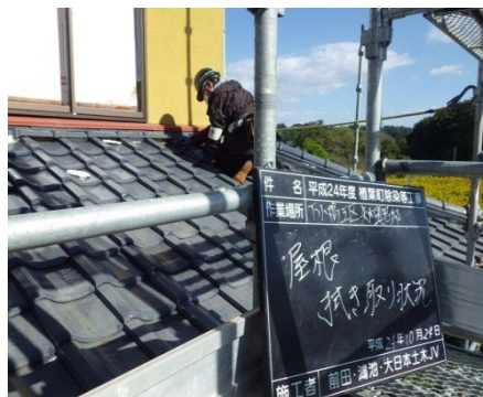
屋根の除染(拭き取り)
