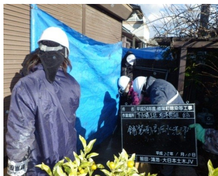
土間等の除染(ブラッシング・高圧水洗浄)
