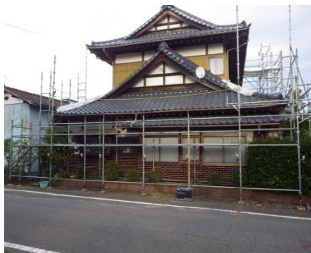
足場の組立て
