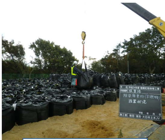
フレコン積み上げ
