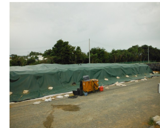
側端部の閉塞・押さえ措置
