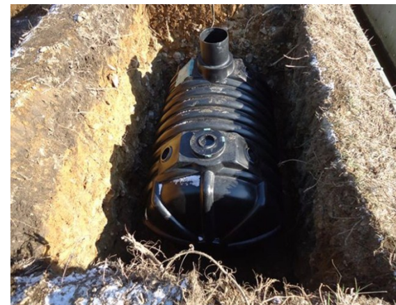
集水タンク敷設
