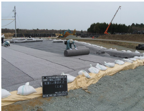
底部シート敷設
