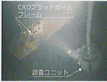
俯瞰カメラの映像1 (調査ユニットの吊り下ろし作業)
