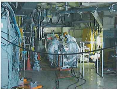
PCV外部 (X-6ペネ) 前での作業
