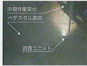
俯瞰カメラの映像2 (調査ユニットの吊り下ろし作業)
