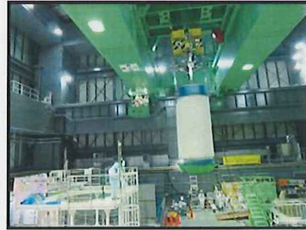
構内用輸送容器を使用済燃料プールへ移動 (撮影日2013年11月18日)
