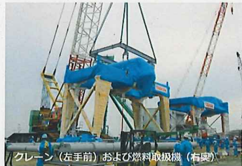
クレーン（左手前）および燃料取扱機（右奥） 燃料取扱機・クレーンの海上から構内に搬入状況 （撮影日2017年11月8日）
