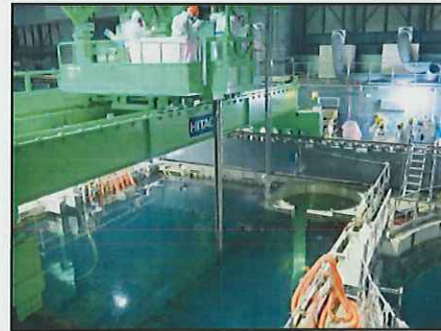
燃料取り出し作業 (撮影日:2013年11月18日)
