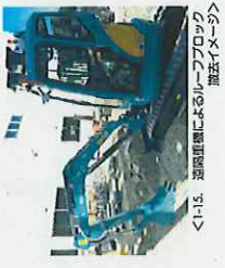
<1-15. 遠隔重機によるルーフブロック撤去イメージ>
