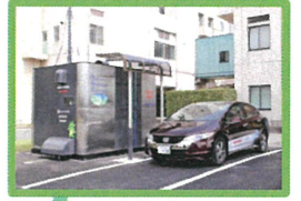
水素ステーション
