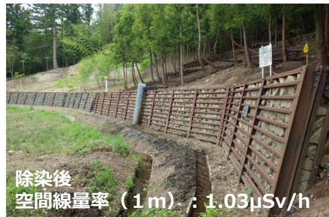
除染後の様子
