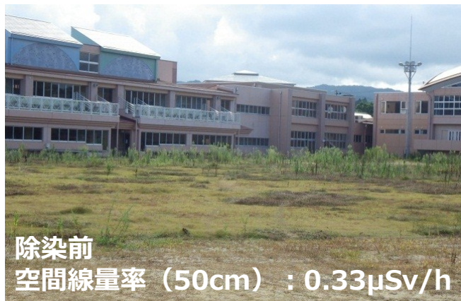
除染前の様子
