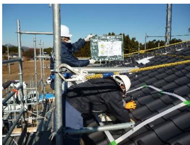
屋根の確認調査の様子
