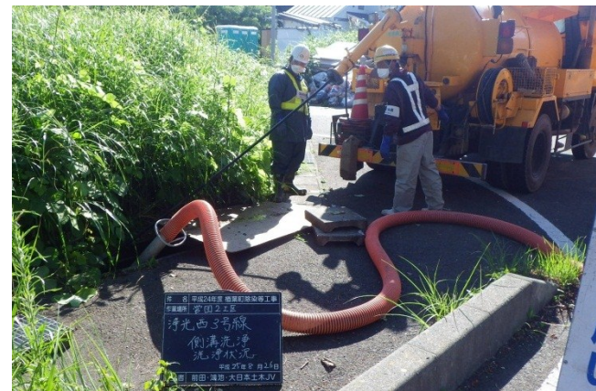
側溝洗浄の様子
