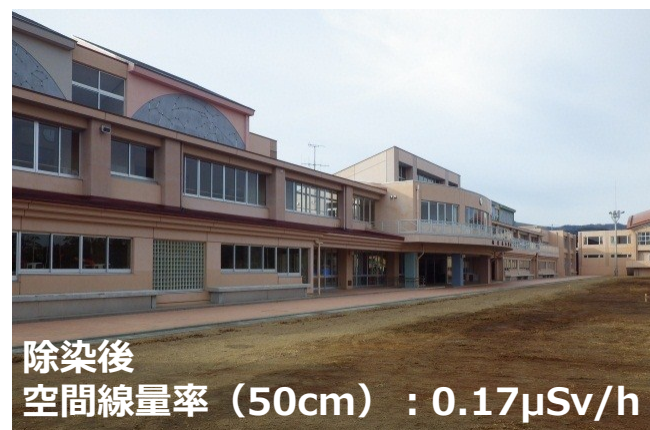
除染後の様子
