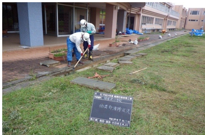
側溝清掃の様子
