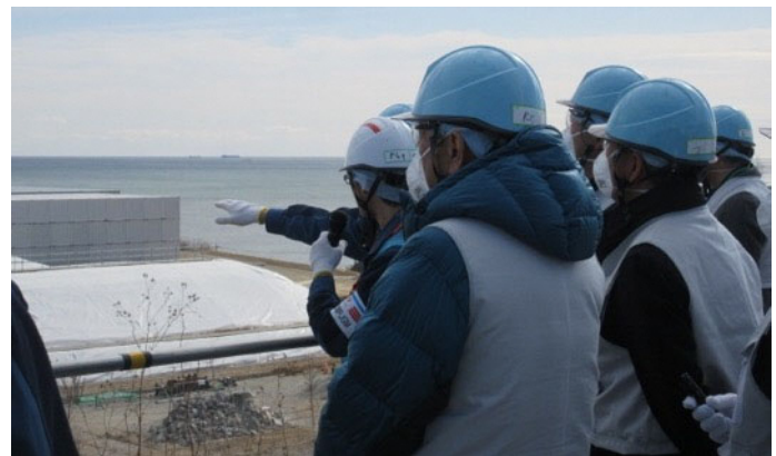
一時保管エリアLの解消作業現場視察
