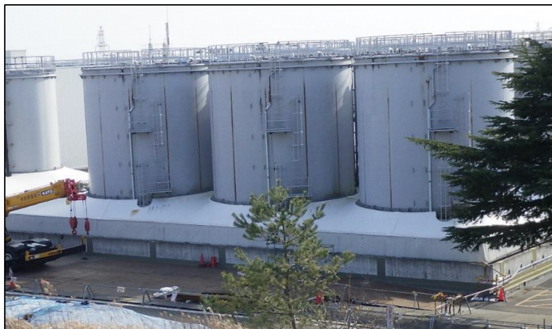
タンク解体前のJ8エリアタンク（2026.1.15）
