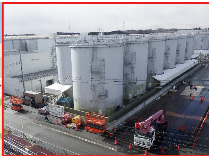
J9エリア タンク解体前の写真
