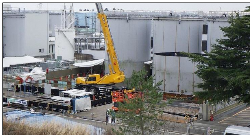
タンク6基目の解体中のJ8エリアタン（2026.4.21）
