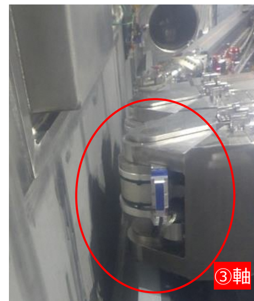
エンクロージャ内確認状況
