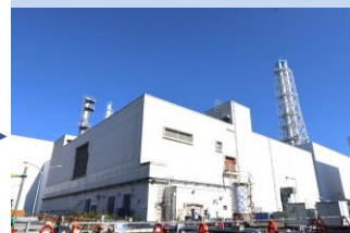
高温焼却炉建屋
