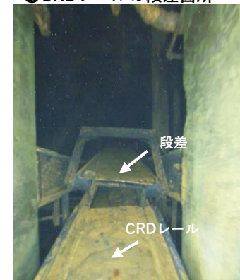
④CRDレールの段差箇所
