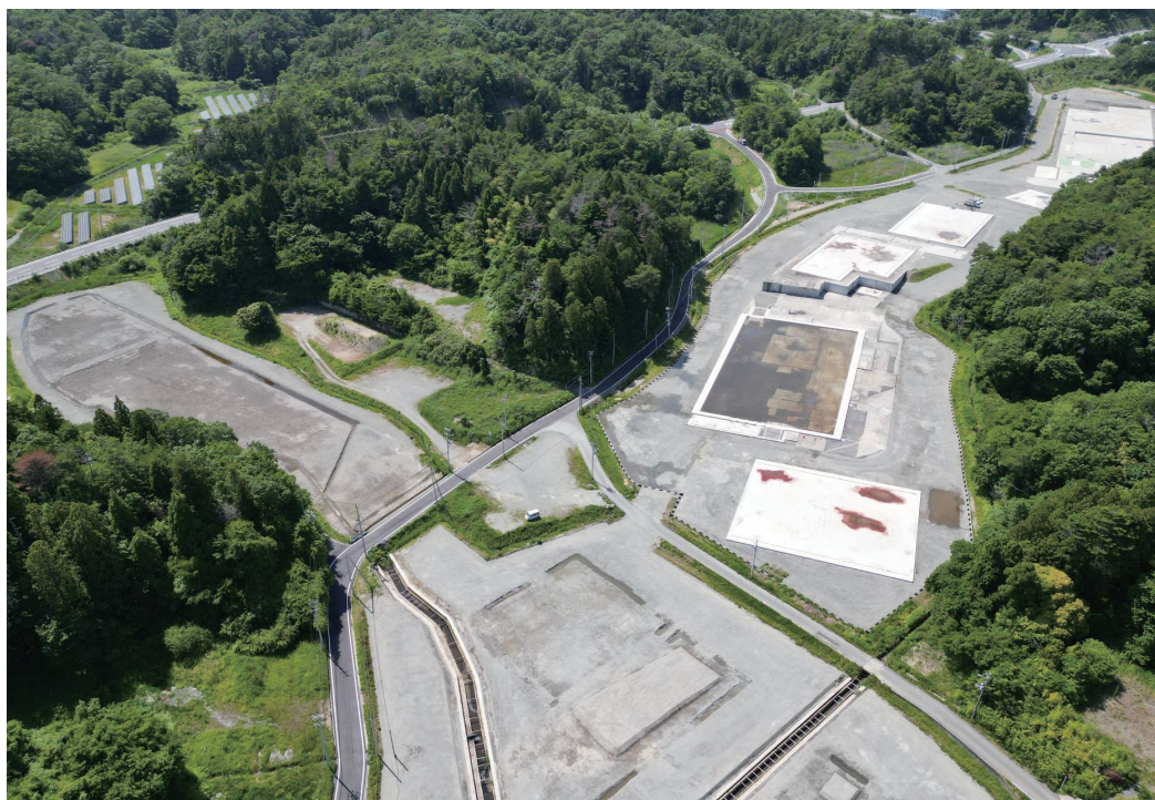
整備が進む波倉産業団地
