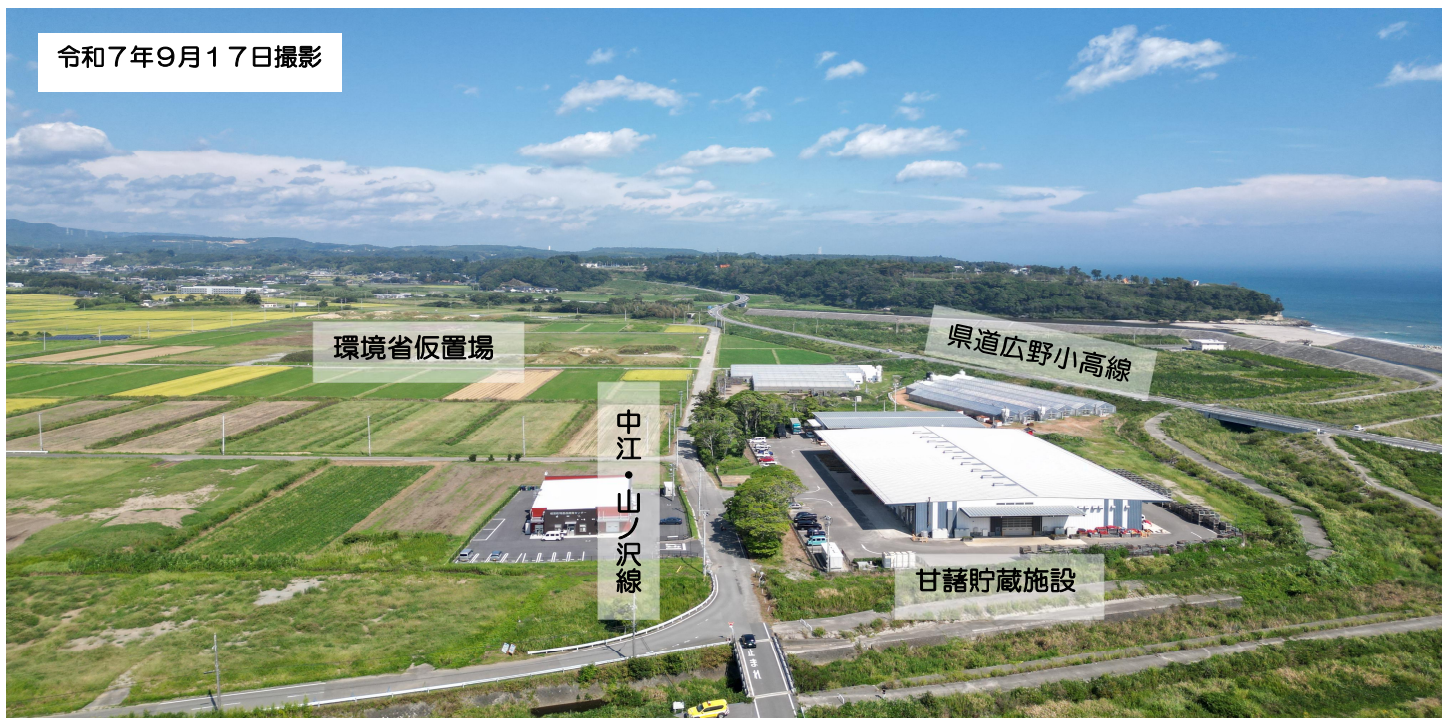
甘藷貯蔵施設から北方向を望む
