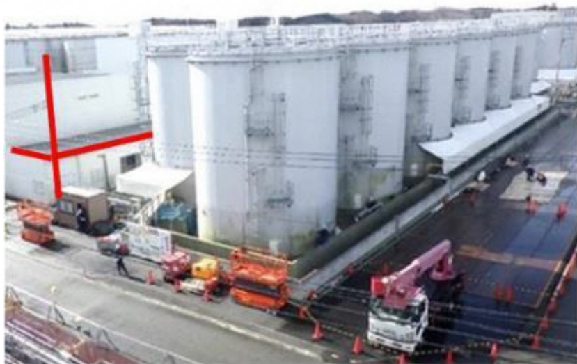
タンク解体前のJ9エリアタンク（2025.2.13）
