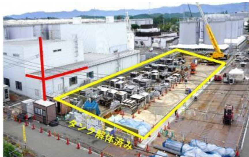
タンク解体完了後のJ9エリアタンク（2025.9.3）
