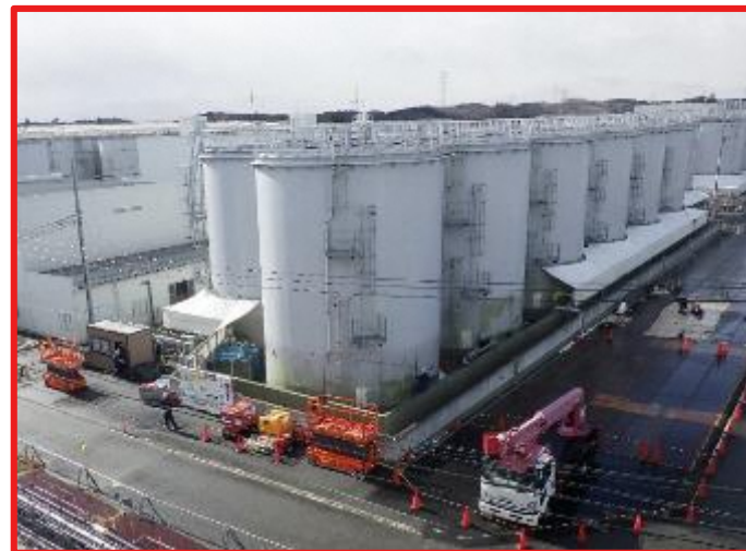
J9エリア タンク解体前の写真
