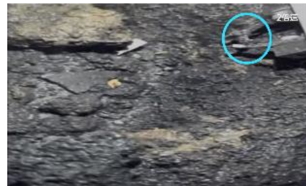
先端治具で燃料デブリを把持した様子（2024.10.30）
