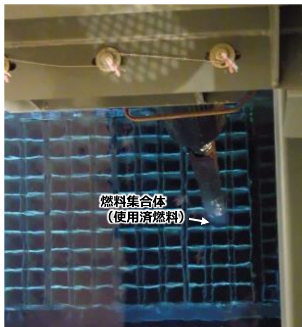
6号機使用済燃料プールからの 燃料取り出しの様子
