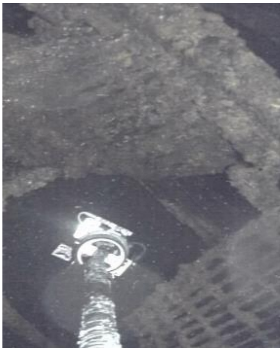
「開口2」上部の状況
