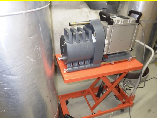
可搬型の核種分析装置による配管付着放射能測定
