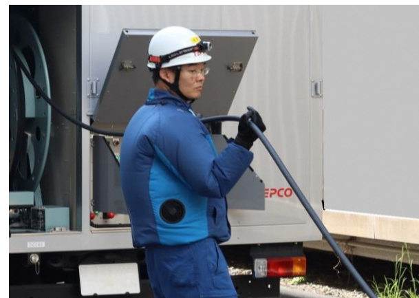
電源車を活用した電源復旧の様子
