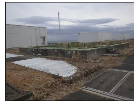
2号炉 薬液タンク解体前・後
