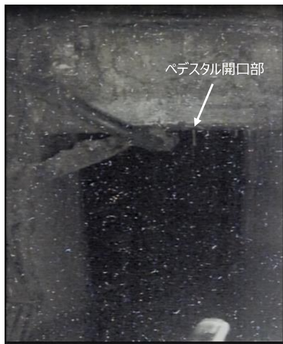
テレスコ式アームカメラの画像（ペDESTAL開口部、プラットホーム開口部の状況）
