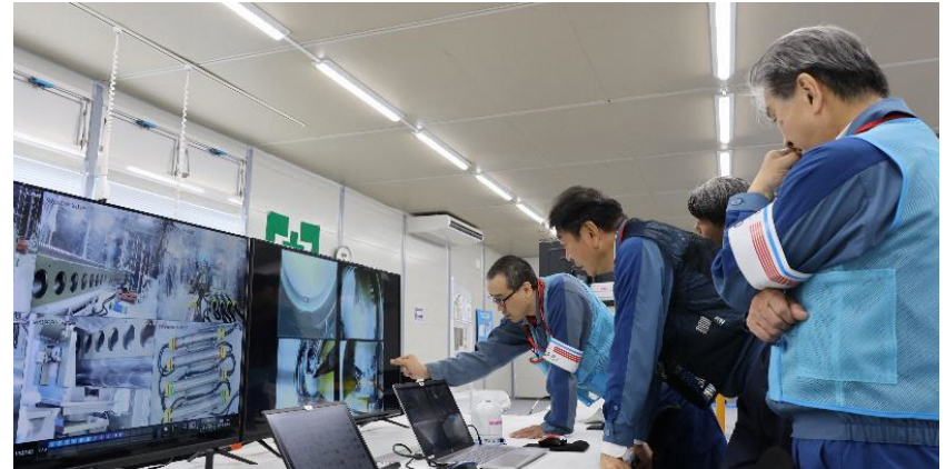
遠隔操作室確認状況
