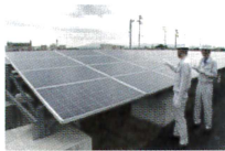
太陽発電設備の検査の様子
