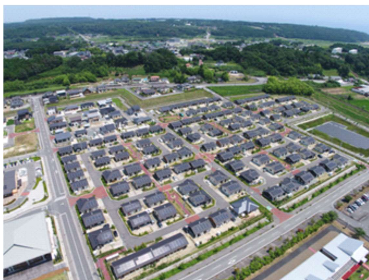
図 2.3-4 太陽光発電システムや蓄電池が導入された災害公営住宅
