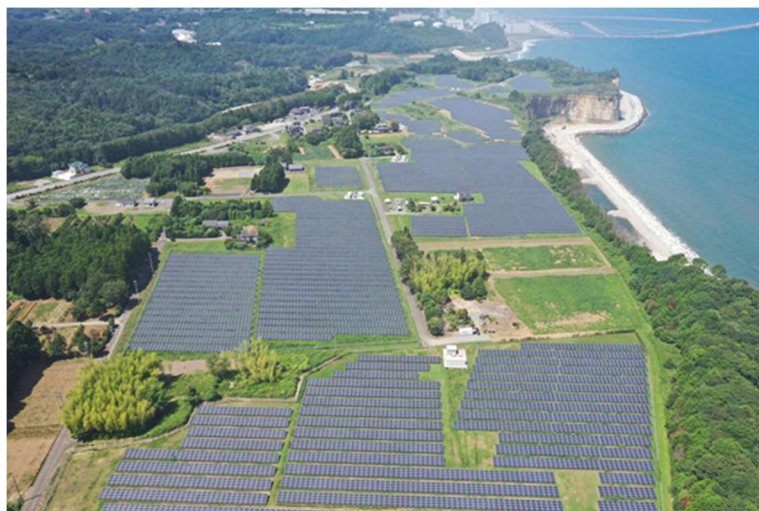
図 2.3-6 波倉メガソーラー発電所
