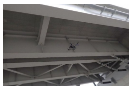
ドローンによる桁下の点検
