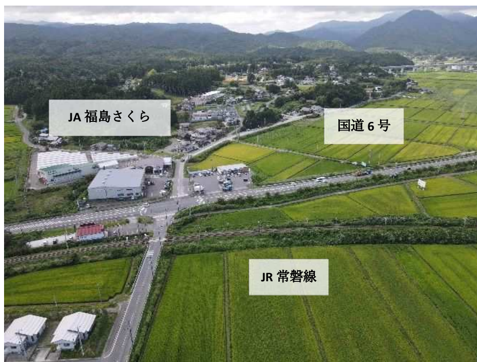
小学校付近から延木戸・袖山川原線を望む
