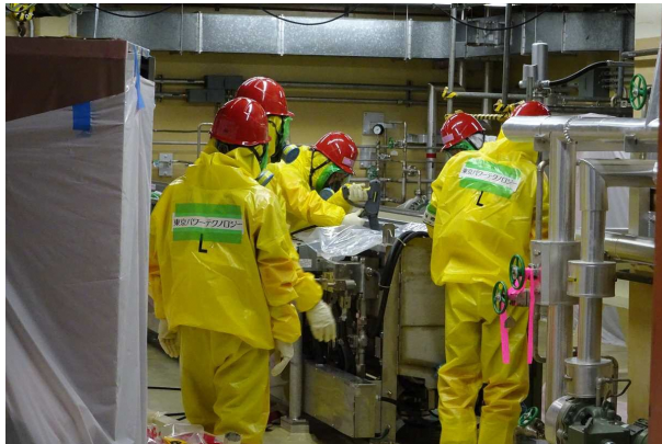
<1号炉除染作業>
