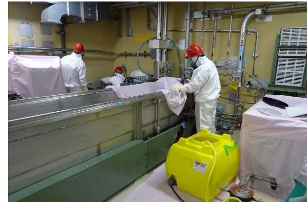
<3号炉除染作業>
