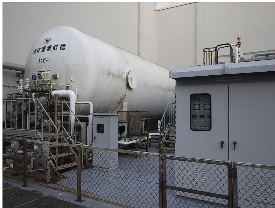
＜格納容器内ガス濃度制御系＞
