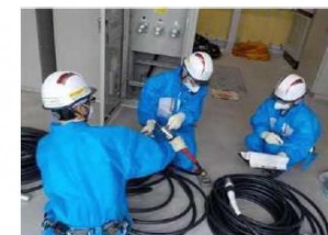
ケーブル導通訓練
