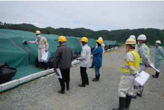
除染廃棄物仮置場における住民監視が開始 (H26. 5. 15)
