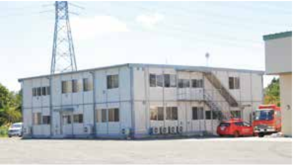
双葉広域消防本部仮庁舎が南工業団地内に開所（H24. 10. 1）
