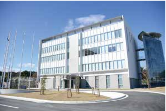
楡葉遠隔技術開発センター研究管理棟完成（H27. 10. 19）
