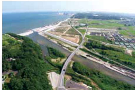
令和2年3月に県道広野小高線の天神工区が開通
