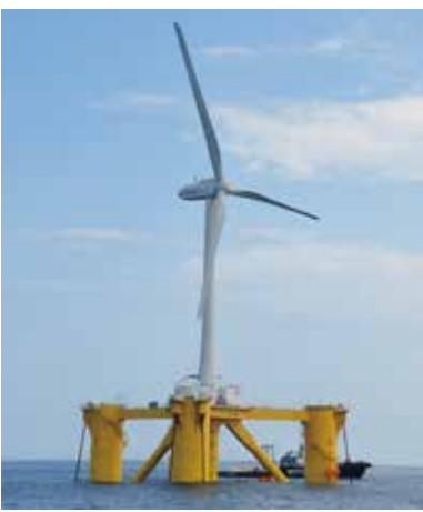
洋上風力発電実証研究事業が楡葉沖でスタート (H25. 7. 13)
