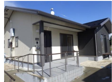
玄関付近外観
