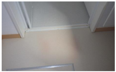
洗面→浴室段差無
