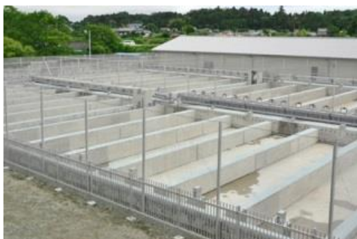
復旧した鮭ふ化施設
