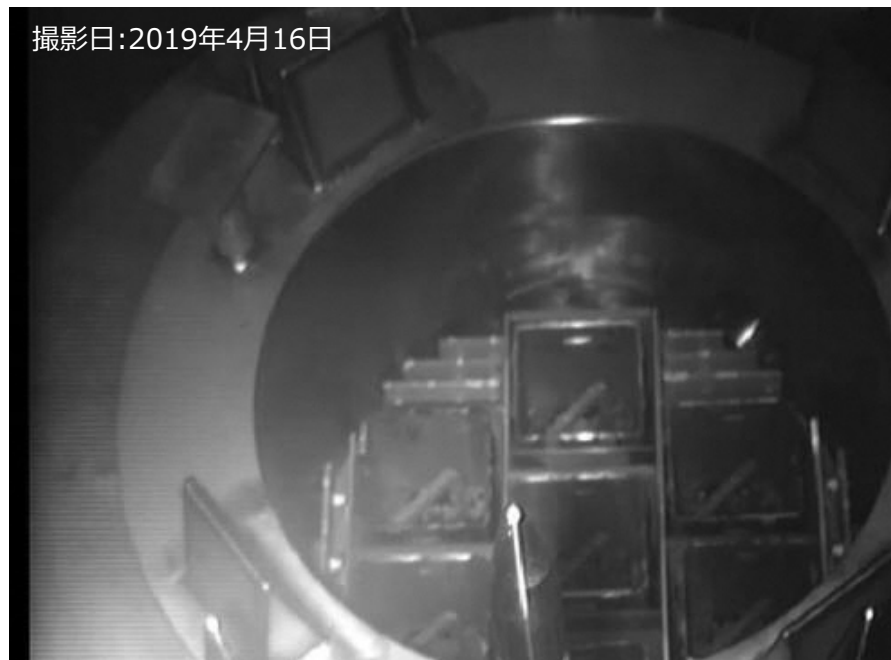
輸送容器へ燃料装填完了(7体)
