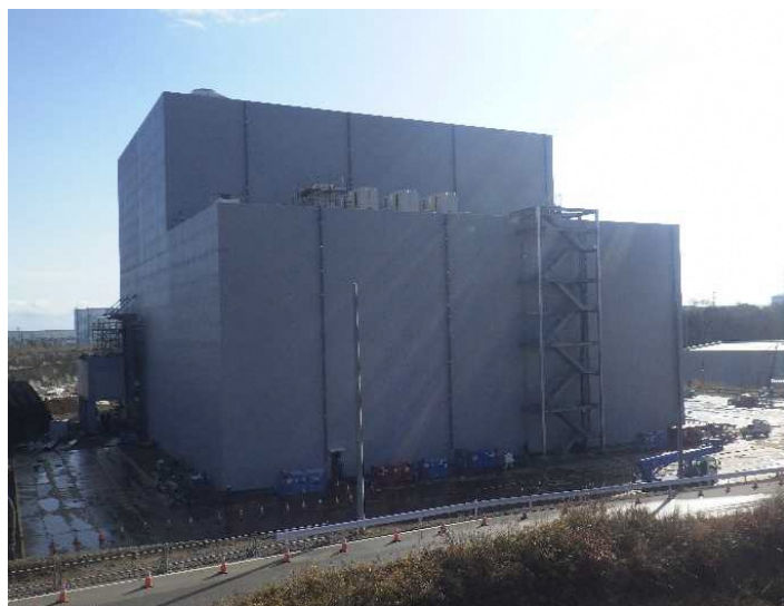
①工事エリア全景
