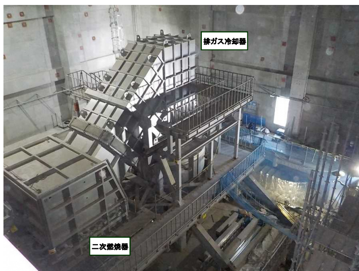
①Ⅱ工区 主要機器設置状況（二次燃焼器、排ガス冷却器）
