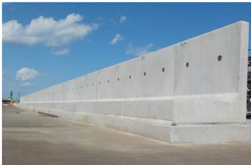
L型擁壁の据付状況（約100m）
