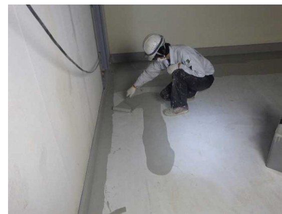
④Ⅱ工区 5F 床塗装工事状況
