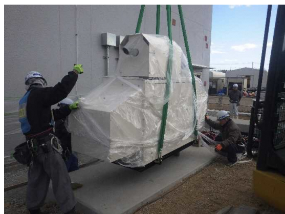
③外部 非常用発電機搬入・設置状況
