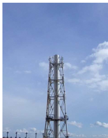
11ブロック解体後 (2020年2月4日撮影)
