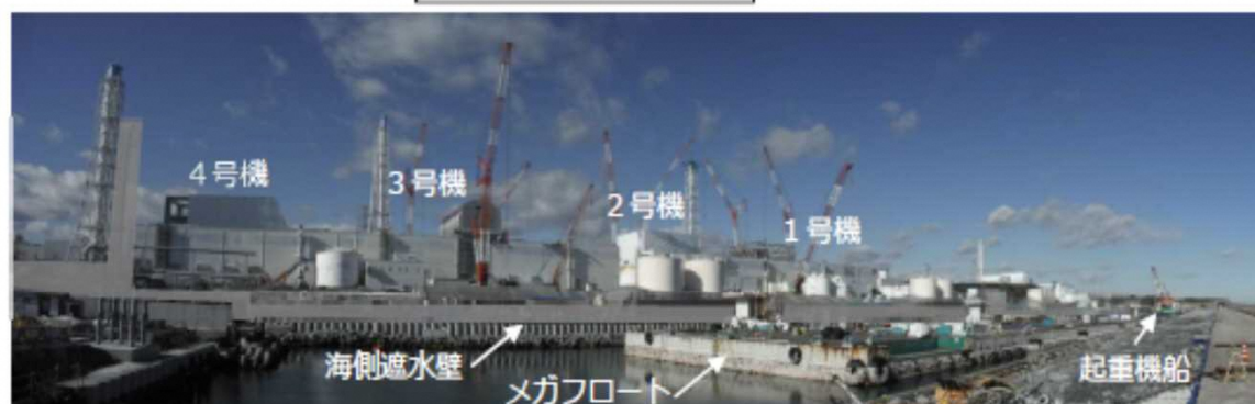
写真①: 1～4号機取水路開渠内でのメガフロート係留状況
