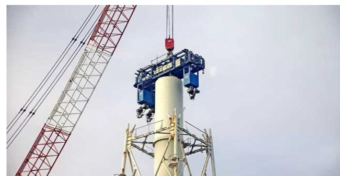
9ブロック目筒身解体作業(1月16日)
