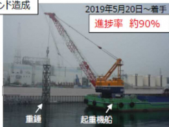
写真③: 起重機船による着底マウンド均し状況
