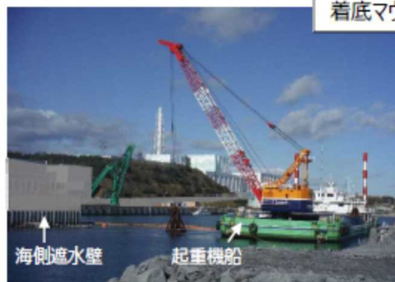
写真②: 起重機船による人工地盤材料投入状況
