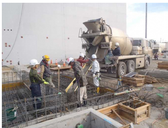
②Ⅱ工区 軽油タンク基礎 コンクリート打設状況
