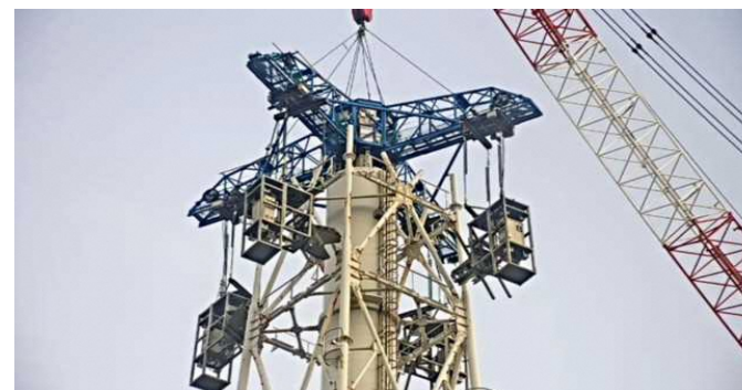
8ブロック目鉄塔解体作業(1月15日)
