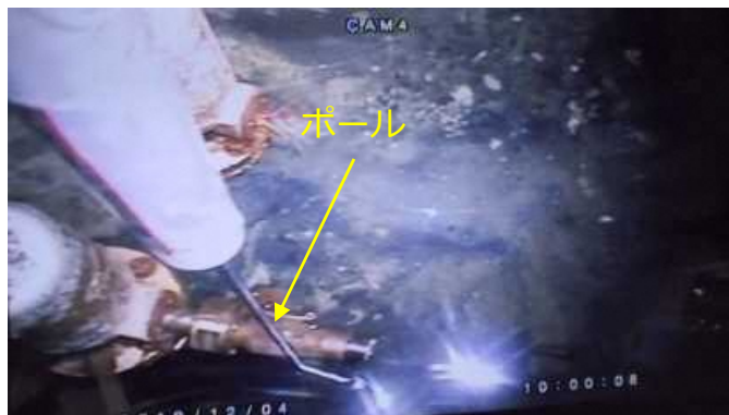
操作ポール挿入前（12/4）
