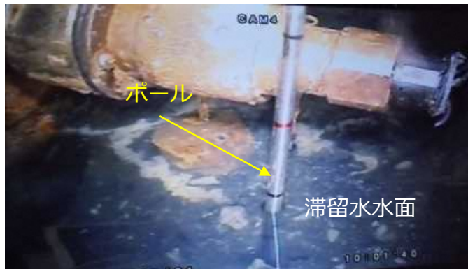
操作ポール挿入後（12/4）
