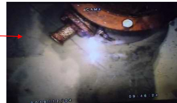
モルタル硬化の様子 (12/4)
