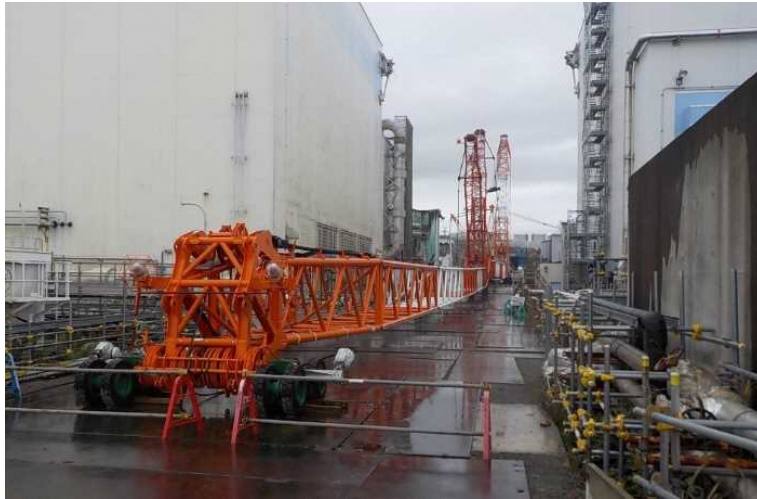
(600 t クレーン)
