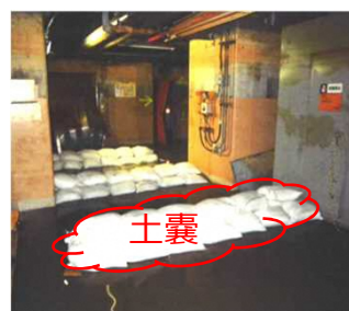
HTIの土嚢状態(設置時)
