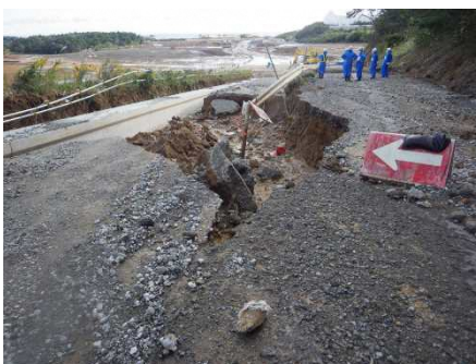
②第二土捨場北構内道路
