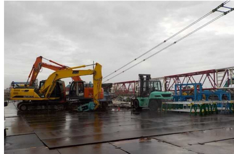
(350 t クレーン)
