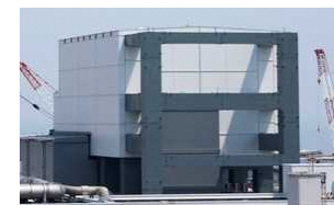
4号機原子炉建屋外観
