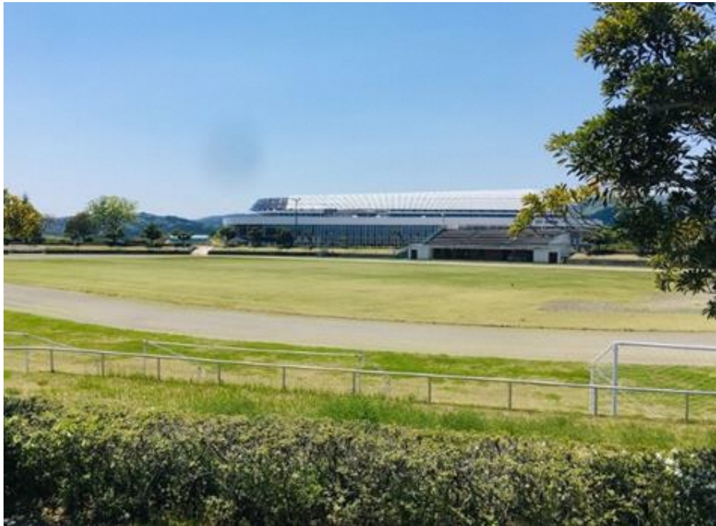
図表 19 檜葉町陸上競技場外観
