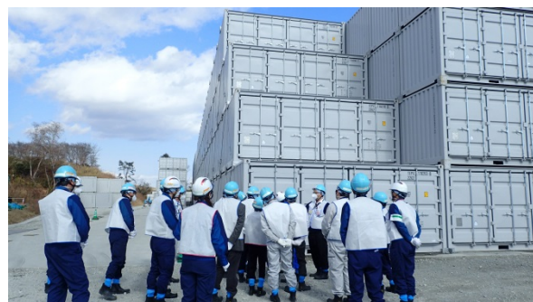
フランジタンク解体片保管施設 （津波リスクが小さい高台に配置）
