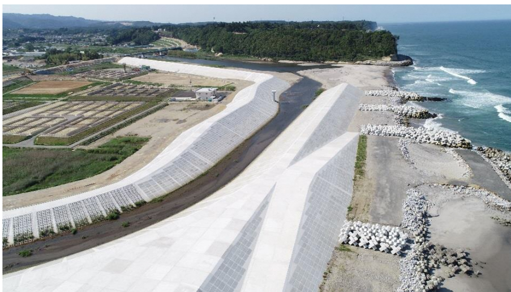
新たに整備された堤防（8.7m）
