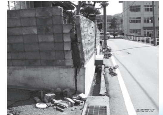
<事例>：倒壊の危険性が高いブロック塀
