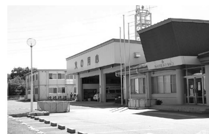
榑葉分署の奥に建設
