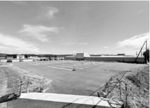
◆小学校北側駐車場 整備事業:49,016千円
