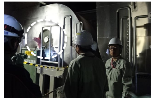
最近起きたトラブル関連箇所② (火災を起こした電動機があった箇所)
