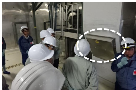
最近起きたトラブル関連箇所① (空気流入を生じた点検口)
