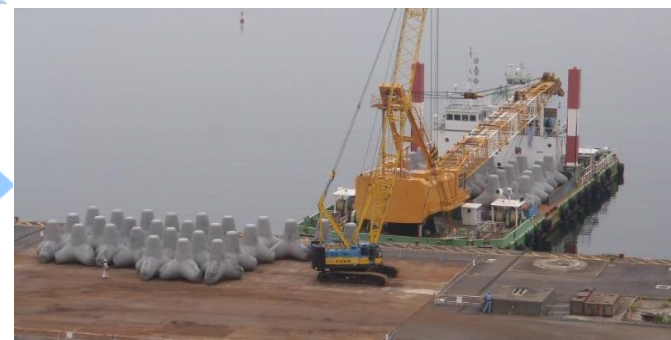
起重機船にて海上運搬
