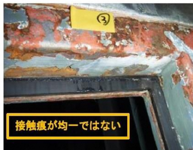
空気流入が確認された箇所の接触痕（扉右上）
