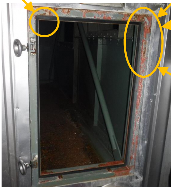
空気流入が確認された箇所の接触痕（扉右上）
