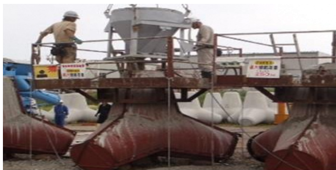
型枠へのコンクリート流し込み
