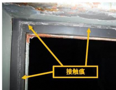
空気流入がなかった箇所の接触痕（扉左上）
