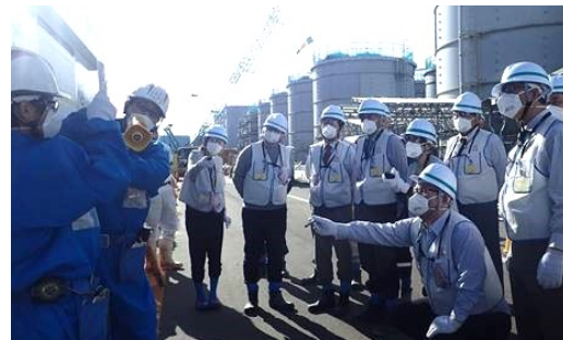
フランジタンク解体について説明を受ける
